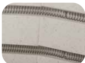
Varmelegemer, monteret beskyttet i riller
