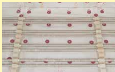
Copertura in tessuto per ridurre le polveri di fibre
