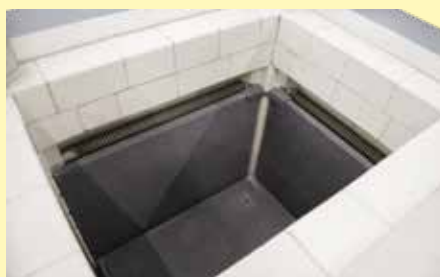
Revêtement des côtés et de la sole avec protection à plaques de carbure de silicium pour four puits S 73/HS
