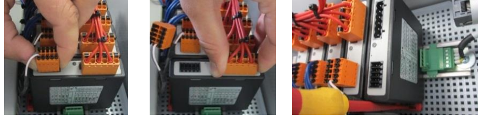
Resim 17: Regülatör modülünün sökülmesi – Bölüm 1 (resme benzer)
